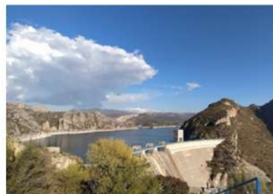
Réservoir de Santa Ana
