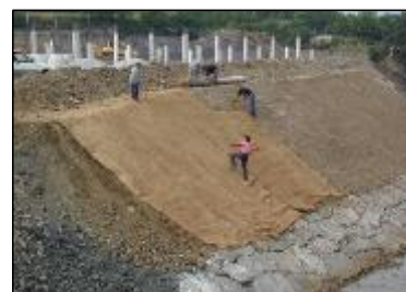
Figure 2-3. Technique d'enduction : mise en place d'une couverture organique. Valentín Contreras (EFIB, Paola Sangalli).
