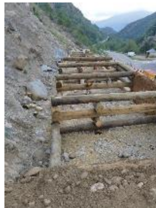
Figure 1-8. Détail des gabions en bois pendant la construction.
