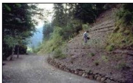
Figure 2-1. Technique d'enrobage : semis à la volée en structure. Florin Florineth (EFIB, Paola Sangalli).
