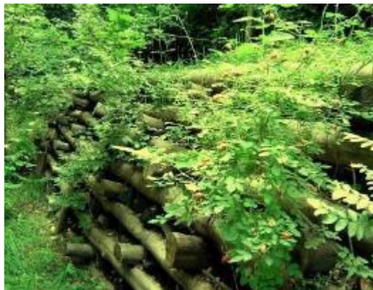
Figure 2-12. Technique mixte. Photo de l'armature en bois autrefois végétalisée (EFIB, Paola Sangalli).
