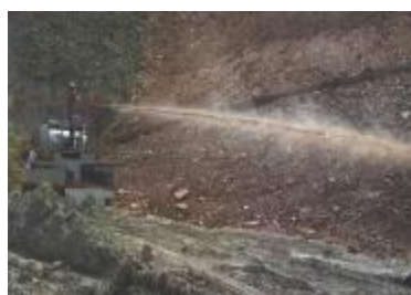
Figure 2-2. Technique d'enrobage : hydroseeding (EFIB, Paola Sangalli).
