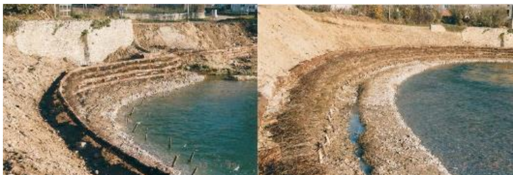
Figure 2-20. Exemple de stabilisation de pente fluviale dans une zone urbaine (Klaus Peklo, EFIB).
