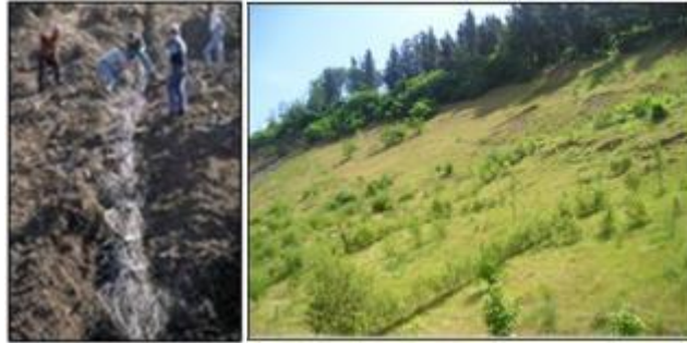
Figure 2-10. Technique de stabilisation. Construction en pente et en chevrons, à Bergara, Gipuzkoa (EFIB, Paola Sangalli).
