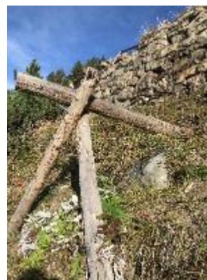
Figure 1-4. Détail d'un trépied en bois, à côté d'un mur en maçonnerie, infrastructure grise.
