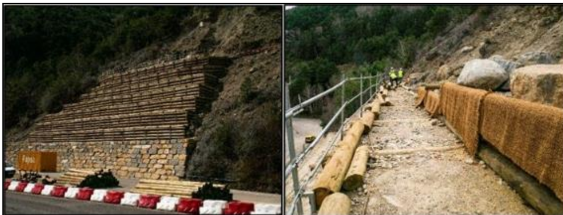
Figure 3-9. Zone de travail dans la tranchée de Santa Elena. La zone de surveillance comprend dix terrasses de 2 m de large et de longueur décroissante (de 30 m pour le niveau le plus bas à environ 10 m pour le niveau supérieur).
