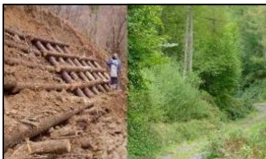
Figure 2-14. Technique mixte. Treillis à Leizaran et après un an (EFIB, Paola Sangalli).
