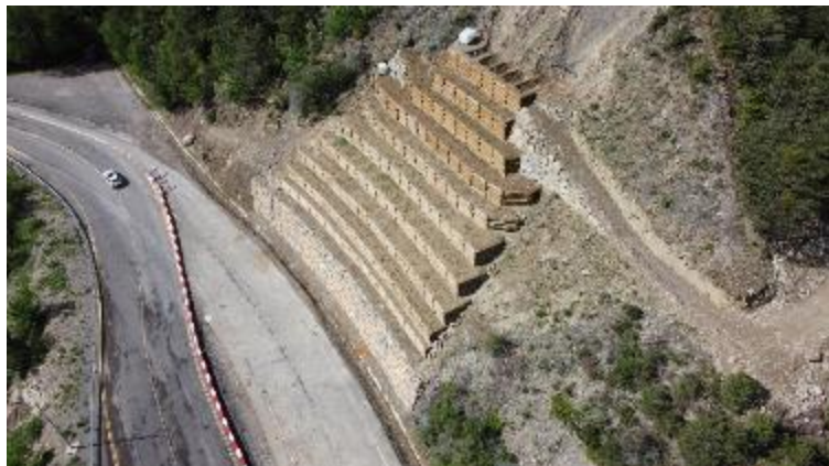
Figure 1-7. Vue d'ensemble du site de Santa Elena, prise avec un drone, avec le mur en maçonnerie et les terrasses en bois à la fin des travaux.
