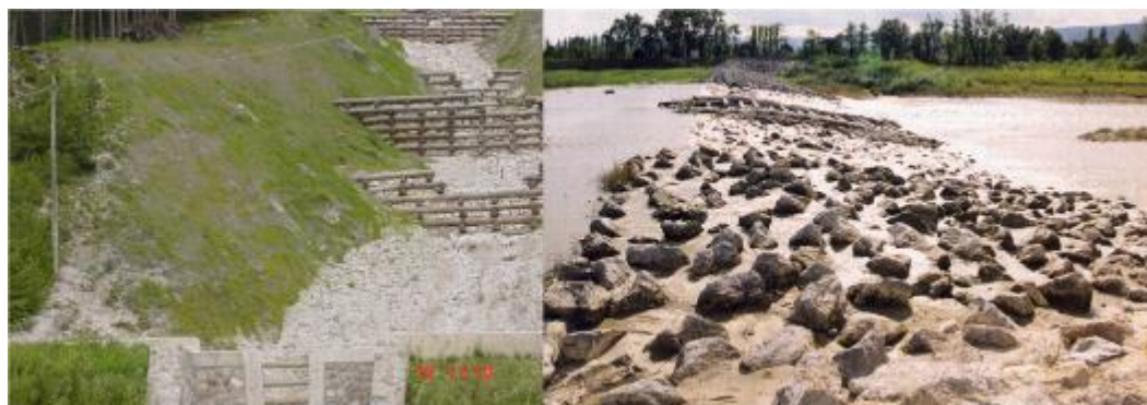
Figure 2-18. Technique complémentaire. Barrages de torrent et rampe à poissons en pierre (EFIB, Paola Sangalli).
