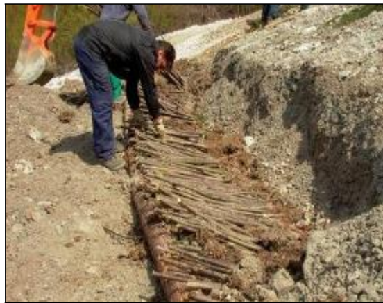
Figure 2-7. Technique de stabilisation. Photo des marches en bois. (EFIB, Paola Sangalli).
